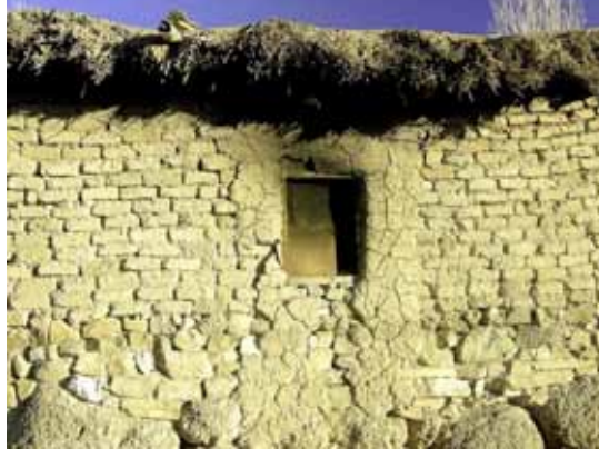
Şekil 2: Kerpiçle örülmüş evin duvarı
