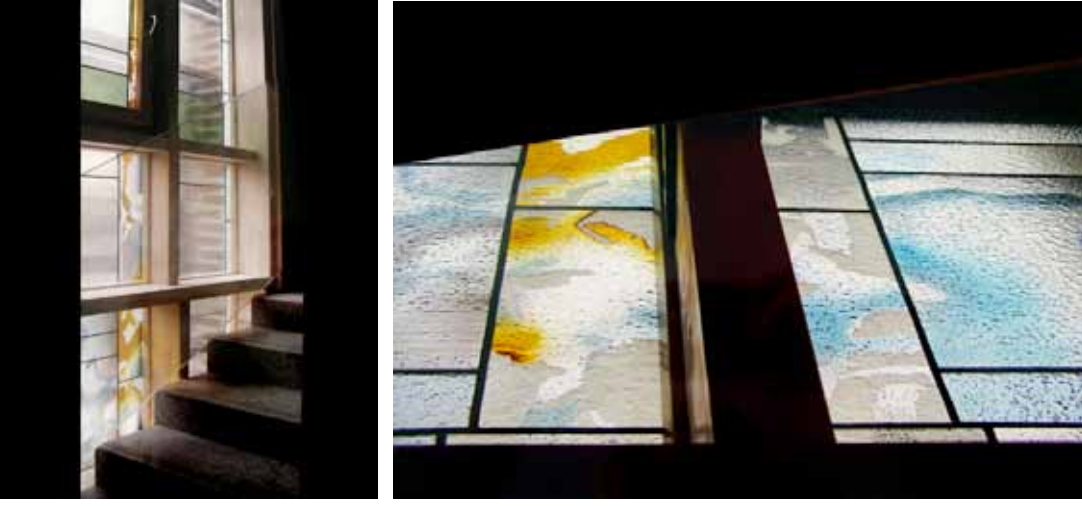
Şekil 4, 5. Litvanya Noter binasının merdiven boşluğundaki vitray pencere (2007). Figure 4, 5. Stained glass window in a stairwell of Lithuania's Notary office (2007).
