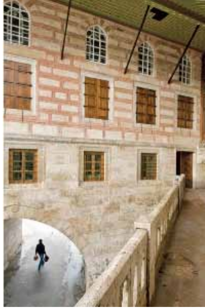
F.6. Hünkâr Kasrının camiye açılan cephesinin görünüşü( İzzet Kehribar arşivi)
