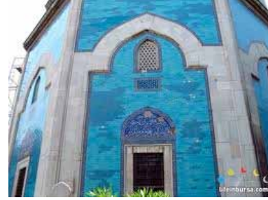
Resim 15: Yeşil Türbe Çini Dış Cephe Kaplaması
