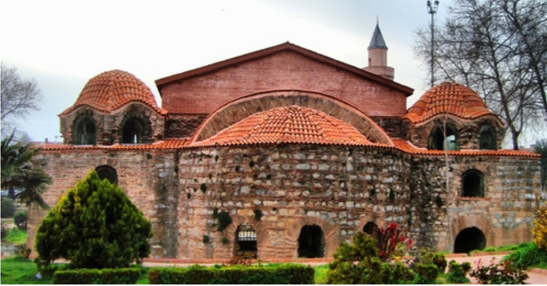
Şekil 4: İznik Ayasofya, üst örtüde kiremit kaplama (Görsel, http://www.ayasofya.org/iznik-ayasofya/417-iznik-ayasofya-camii.html den alınmıştır ).
